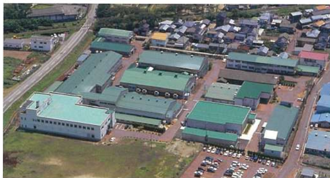
本社・工場 Head Office・Factory
